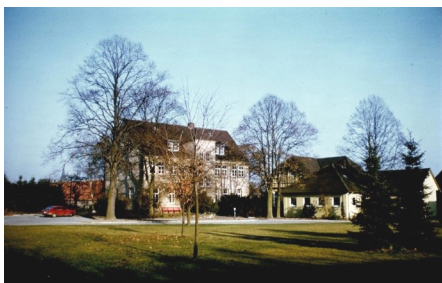
Pollertshof vor dem Umbau
