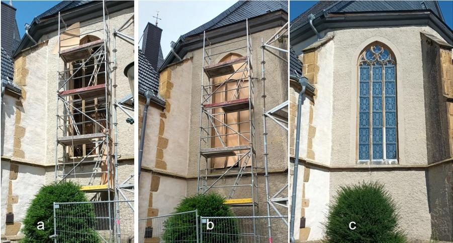
(a) Chorfenster auf der Südostecke mit Gerüst und Reparatur der Verstrebungen, (b) mit zusätzlichem Wetterschutz und (c) mit neuer Ansicht hinter Schutzglas
