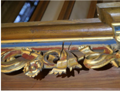
Risse im Blattwerk durch Temperatur- und Feuchtigkeitseinfluss.
